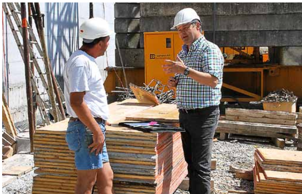
Wenn Danilo Ronzani (rechts) Baustellen kontrolliert, wird auch ernsthaft diskutiert.
